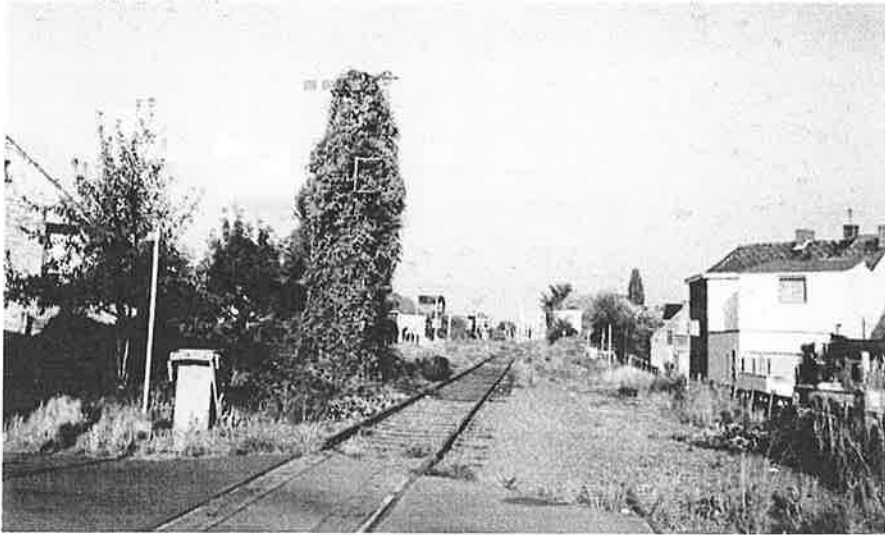
Komend van Frankrijk ontmoet men het mechanische inrijsein van Quiévrain: alléén de "gesloten" seinarm is niet met klimop bedekt. Foto's: Noël Suys, 13 september 1995.
